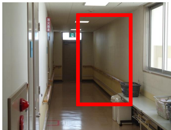
図8. 鉄製の棚を撤去し、避難経路確保
